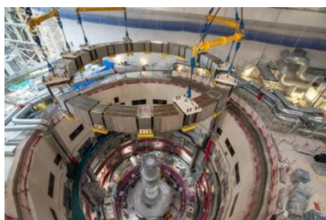
ITER实验堆PF5线圈安装现场
